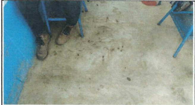
Foto 2: Sustitución de entortatada por piso ceramico Aula 2
