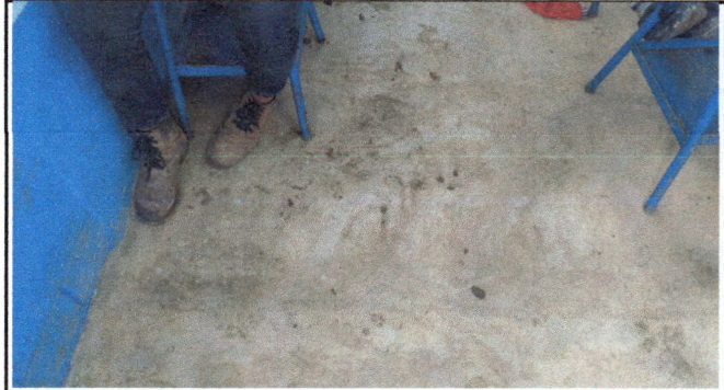
Foto 2: Sustitución de entortatada por piso ceramico Aula 2
