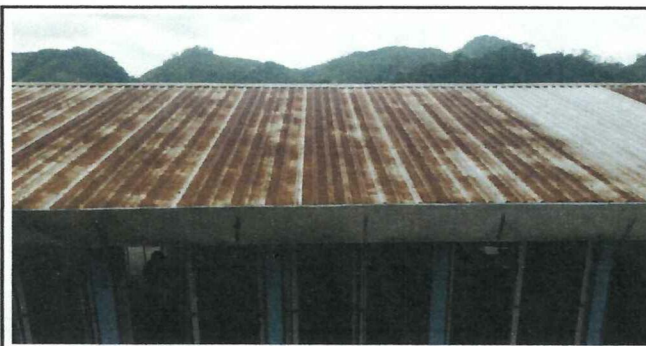
Foto 5: Se observa las condiciones de las laminas troqueladas. La necesidad de lijado
